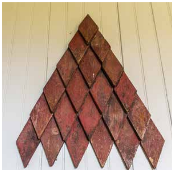
Nokre av dei originale sponene frå taktekinga på tårnet i 1908 er tekne vare på og utstilte i våpenhuset. Spontekkinga blei skifta ut med kopar ca. 1960.
