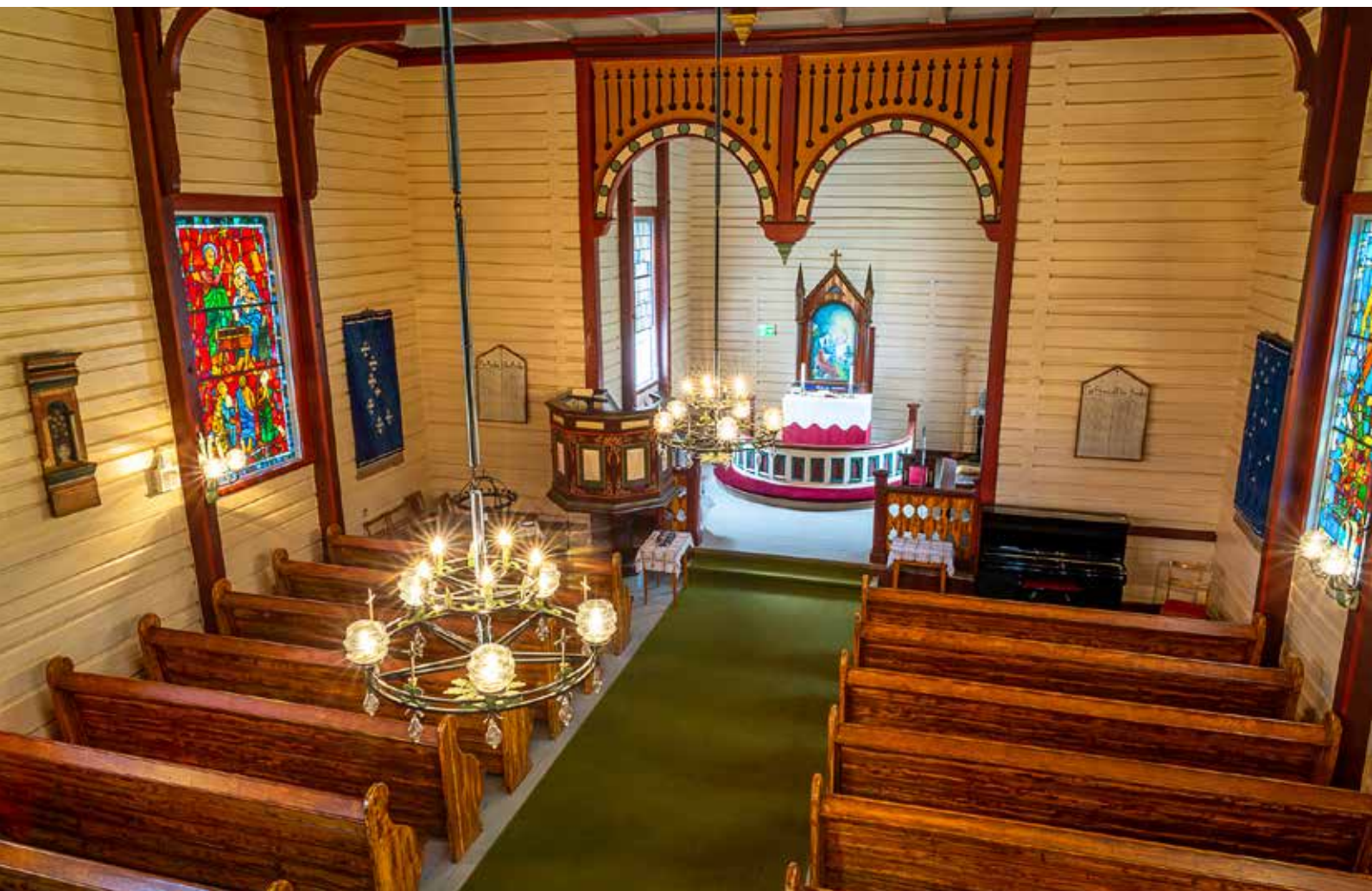
Kyrkja er ei klassisk langkyrkje med rektangulært skip og smalare kortilbygg. Interiøret står med synlege tømmerveggar, strekkfiskar og loftsbejkar. Inventaret er i hovudsak originalt frå kyrkja blei bygd i 1869.
