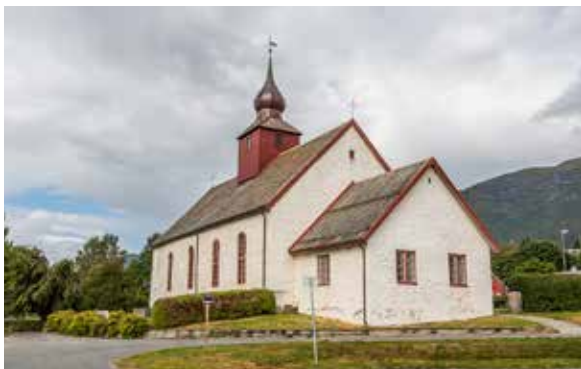
Kyrkja sett frå søraust. Kyrkja fekk bygd til våpenhus og sakristi i 1901–02, men desse blei fornya med dagens sakristi frå 1960 og våpenhus frå 1968.
