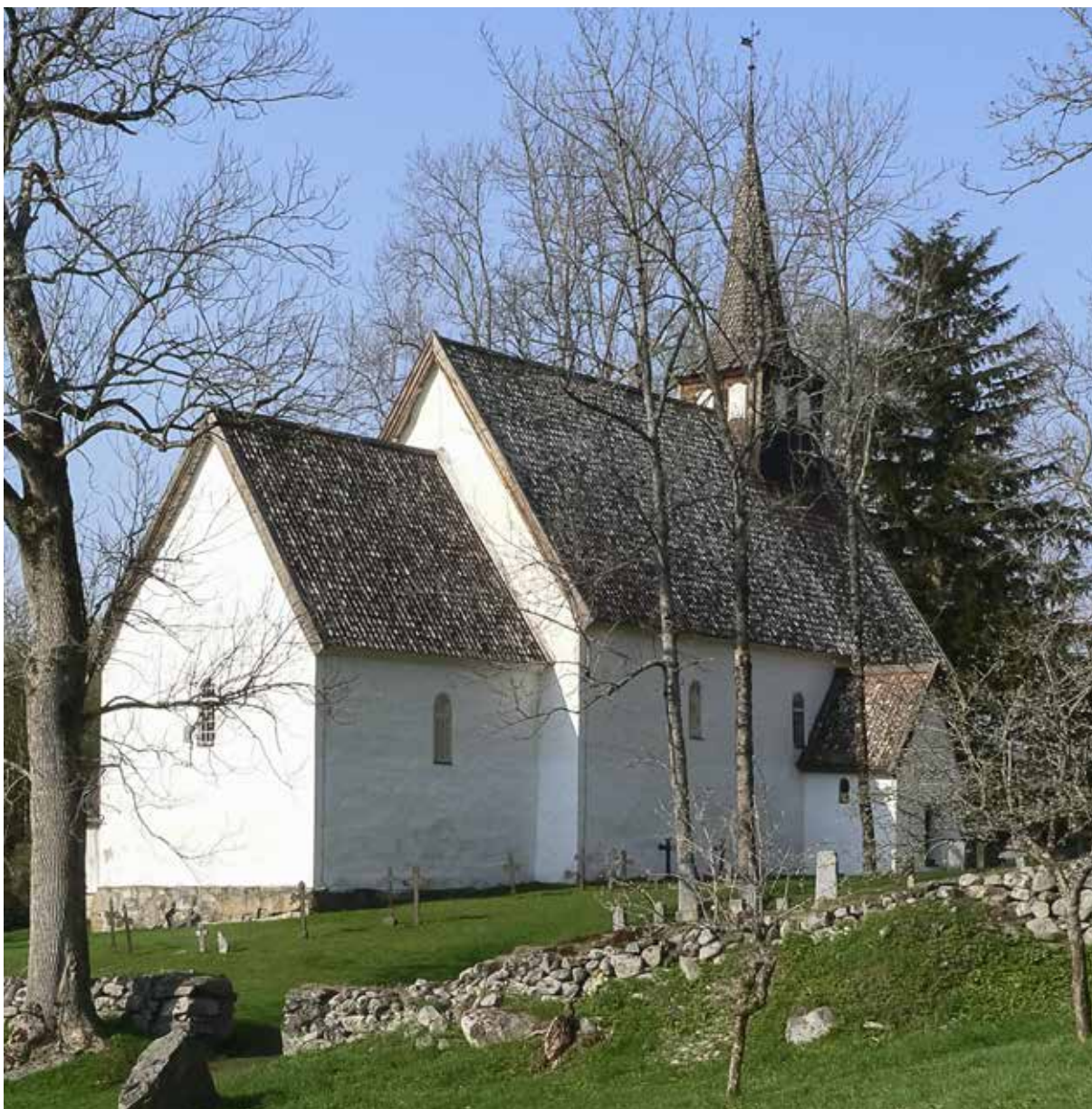
Kyrkja og kyrkjegarden er i dag freda og heile «Nordøya» er verna som natur- og kulturlandskap. Kyrkjegarden er ikkje lenger i bruk og berre nokre få gravminne står att. Kyrkjegardsmuren er framleis intakt. Foto: Morten Stige.
