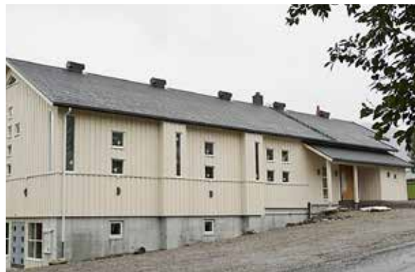
Kyrkjelydshuset ligg nord for kyrkja. Underetasjen stod ferdig i 2010; hovudetasjen er under arbeid i 2021. Mykje blir gjort på dugnad. Arkitekt: Berge Hjørungnes. Entreprenør: Odd Bjerkevoll A/S. Foto: Ivar Magne Bergheim.
