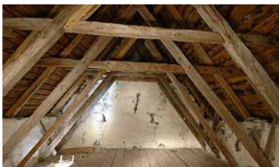
Takverket over koret er datert til første halvdel av 1500-talet. Det består av parallelle sperrepar som kviler på horisontale bindbjelkar mellom murveggane. Sperrane har høg hanebjelke og er innmura i forhøgningar av murkronene. Dette tyder på at taket tidlegare har vore oppe og at loftsgolvet er lagt sidan. Foto: Kjartan Prøven Hauglid.
