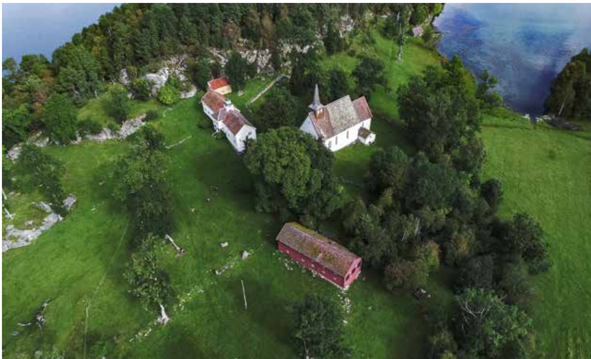
Bildet viser dagens bygningar på Veøya frå lufta. Nordvågen til høgre i bildet. Mot nord prestegarden og bårstua frå 1664. Mot sør løa. I midten kyrkja med kyrkjegarden ikring. Til venstre for bygningane ligg dei gamle kyrkjegardane der det er funne kristne graver heilt attende til 900-talet. Delar av steinmurane er framleis synlege. Foto: Johnny Bratseth/Romsdalsmuseet.
