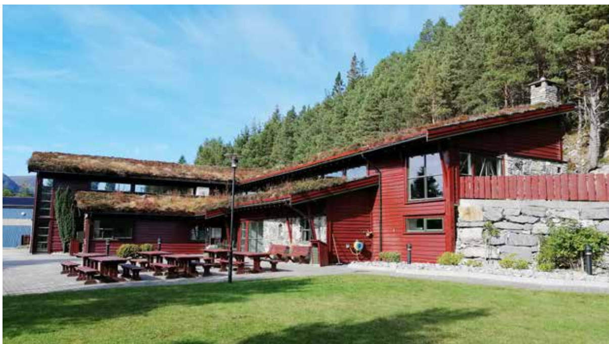
Hovudbygget i Julsundvegen 903 blei innvigd i 1999. Bygget fekk Molde kommunes byggeskikkpris i 2001. Foto: MIM.
