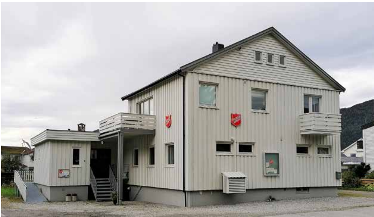
Frelsesarmeen sitt hus i Gamle Romsdalsvegen 22 på Åndalsnes blei innvigd i 1955. Alle foto: MIM.
